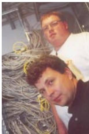
Patrik Carlsson, systemansvarig, och Magnus Larsson, nätverksansvarig, i "kabelkällaren".
